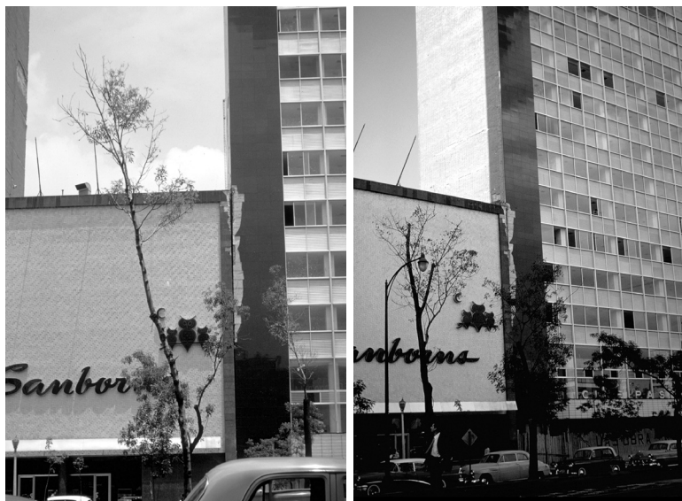
Σχήμα 6.3.1 Δύο εικόνες βλάβης λόγω σύγκρουσης του κτηρίου Sanborns (του χαμηλότερου) και του κτηρίου επί της Λεωφόρου Reforma 33 (του υψηλότερου), στην πόλη του Μεξικού, εξ αιτίας του σεισμού του Μεξικού, στις 28 Ιουλίου 1957. (Απ' τη συλλογή Steinbrugge, με την άδεια του PEER-Εθνικής Υπηρεσίας Πληροφοριών για Σεισμική Μηχανική, του Πανεπιστημίου της Καλιφόρνιας στο Berkeley).
